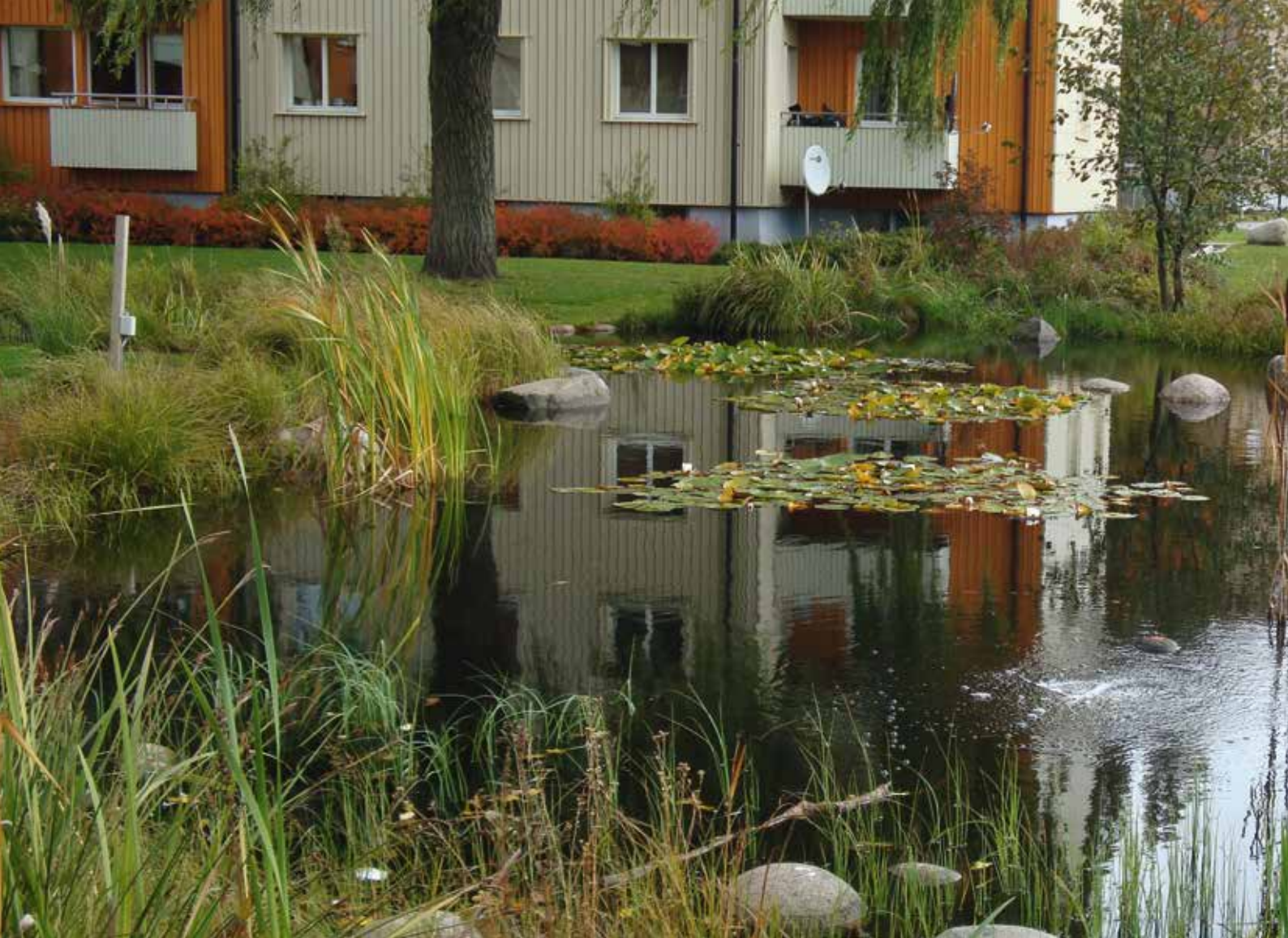
Födröjningsdamm i Augustenborg, Malmö.
