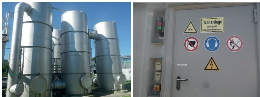
Figur 8.5 Ozonreaktorer (6-32 m 3 ) och ozongenerator (EX-klassat utrymme)
