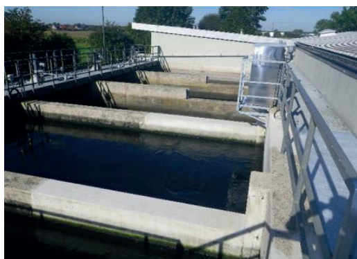
Figur 8.1 Sandfilter vid reningsverket i Dülmen. De två filtren längst ner i bild har byggts om till kontaktreaktorer.
