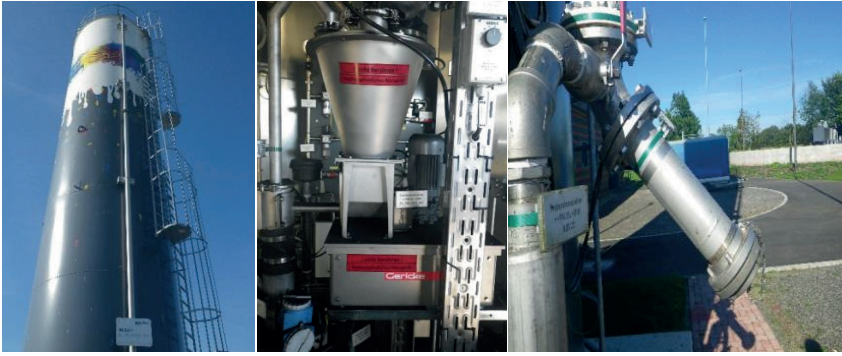
Figur 8.2 Silo för förvaring av PAK, vortextvåg för invägning av rätt mängd PAK och påfyllningsrör till silon. PAK blåses in i silon med hjälp av kvävgas och fyllning tar 2,5 timmar.
