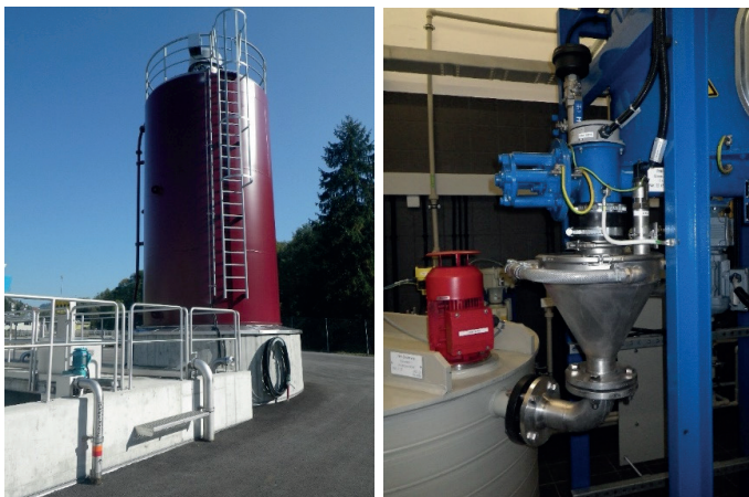
Figur 7.4 Lagrings- och vätningsutrustning.
