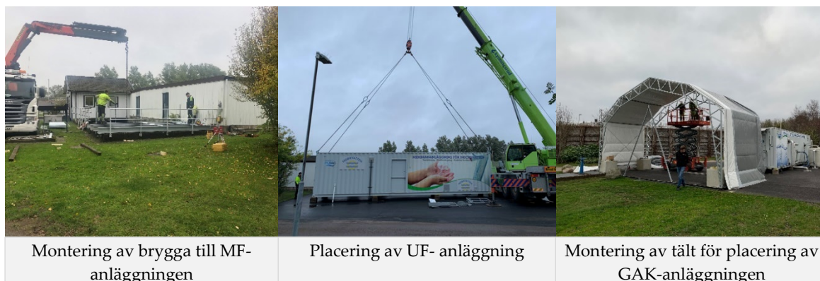
Figur 5. Installation av pilotanläggningarna (MF, UF och GAK-anläggning).
