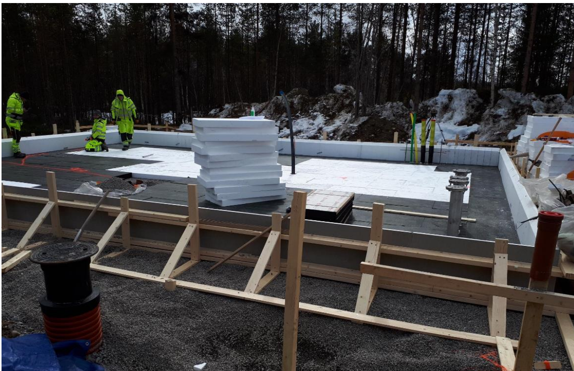
Figur 30, Formsättning och isolering inför grundläggning
