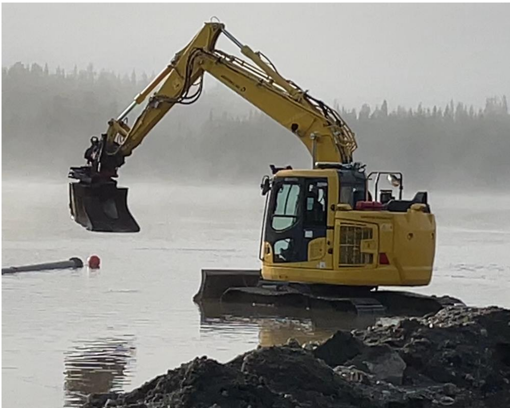
Figur 35, Grävarbeten för installation av brunn för spolvattenförsörjning
