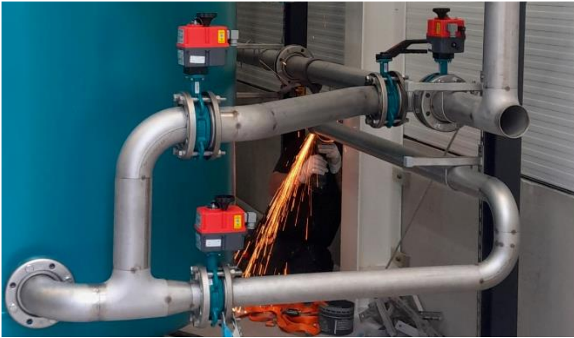
Figur 33, Installationsarbeten av processvattenrör & tankar
