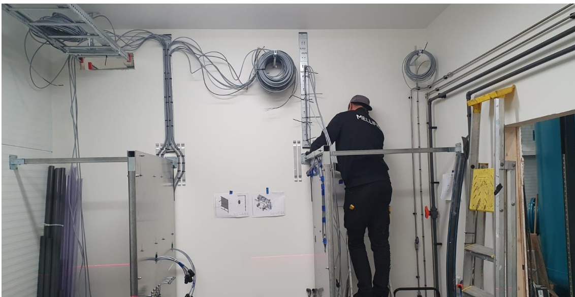
Figur 34, Installationsarbeten för ozonsystemet
