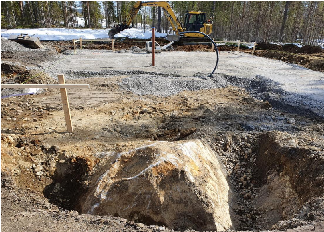
Figur 29, Markarbeten inför grundläggning
