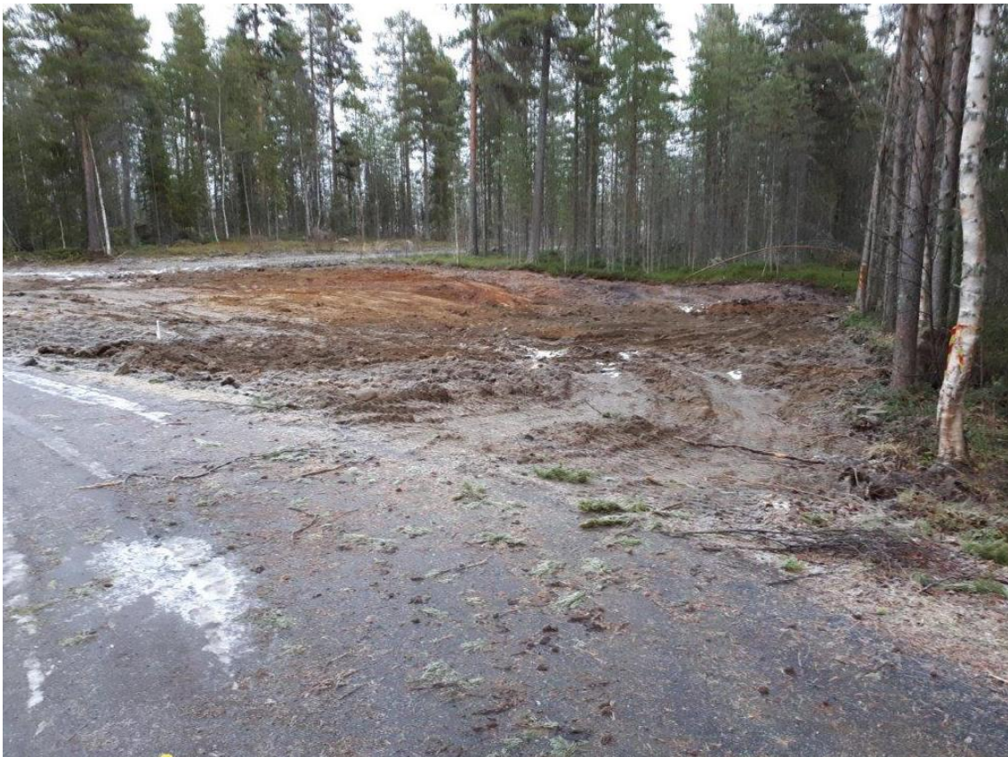
Figur 28, Avsedd byggnadsyta efter averkning och markavtäckning
