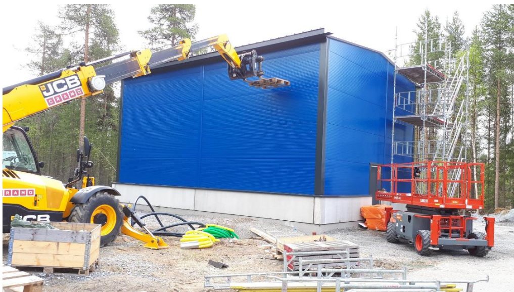
Figur 31, Montage av hallbyggnad
