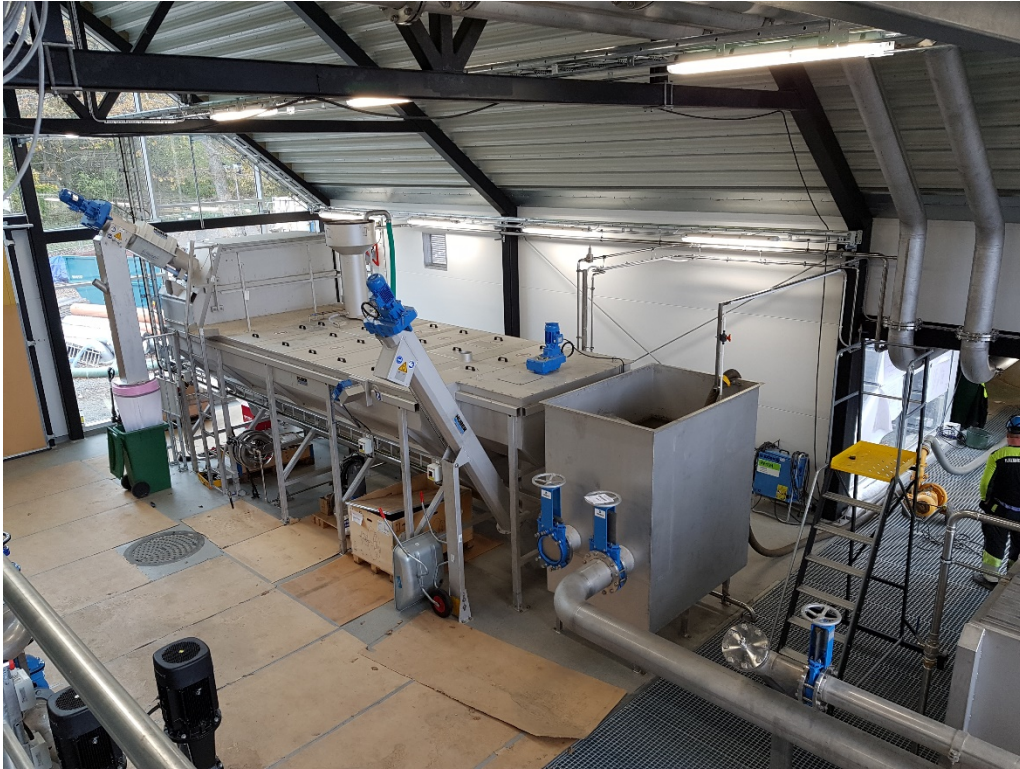
Del av processhall under montageskede.
