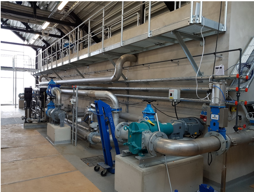
Del av processhall under montageskede.
