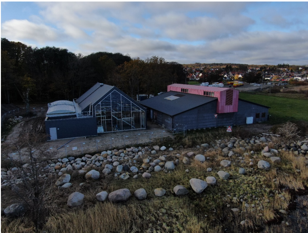
Färdig anläggning (ny till vänster och befintlig till höger)
