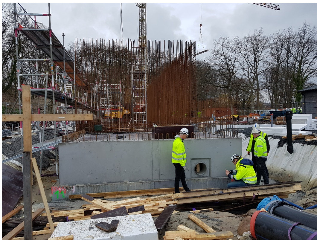
Inspektion gjutning utgående ledning.
