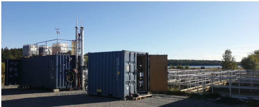
Figur 4 Pilotanläggningen med nitrifikationstankar på taket och 5 m höga ozonkontaktkolonner. Akvariecontainern för fiskeexponering i förgrunden, eftersedimentering och Norrtäljeviken i bakgrunden.
