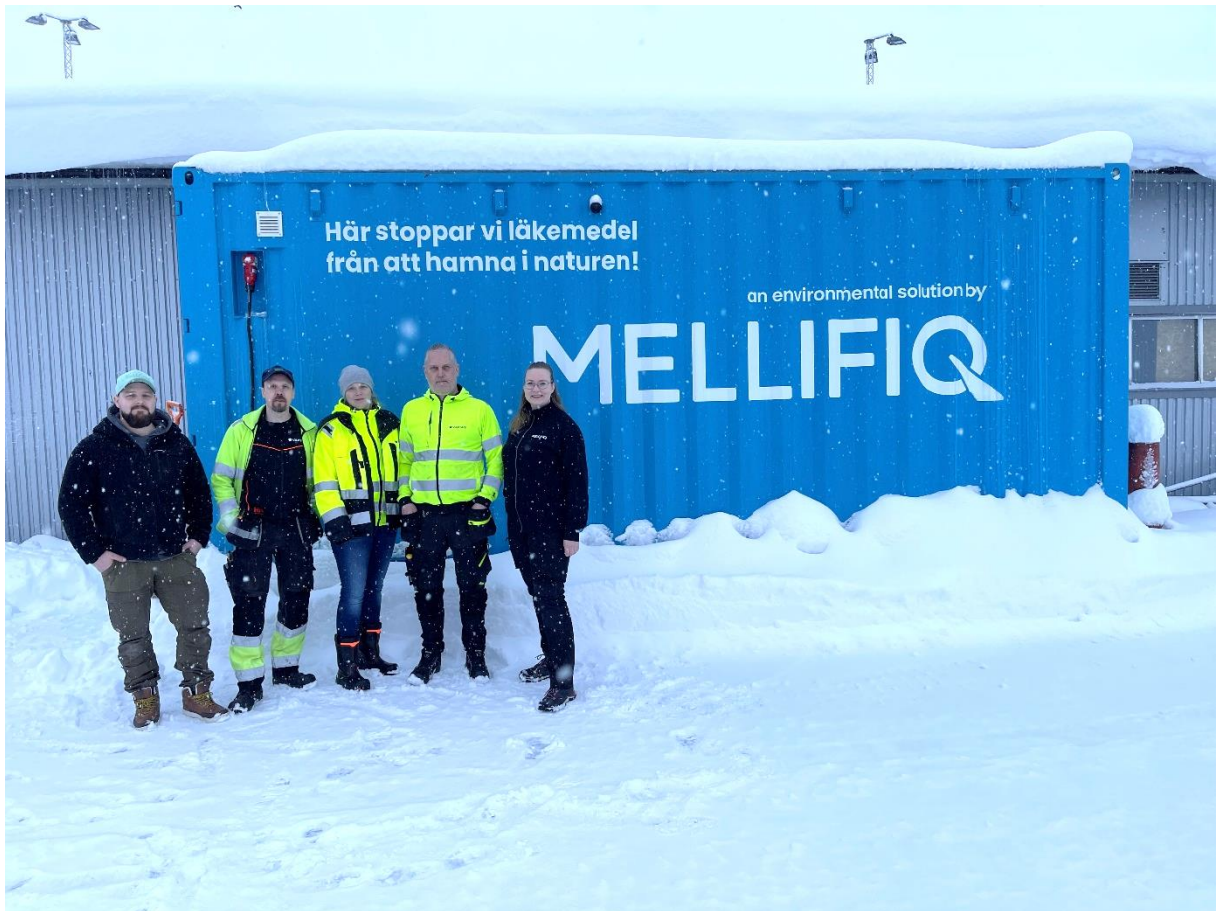
Figur 9. Det containerbaserade avancerade vattenreningssystemet installerat vid Sälkfällets ARV.
