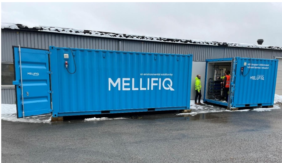
Figur 7. Det containerbaserade avancerade vattenreningssystemet installerat vid Hammargårds ARV.
