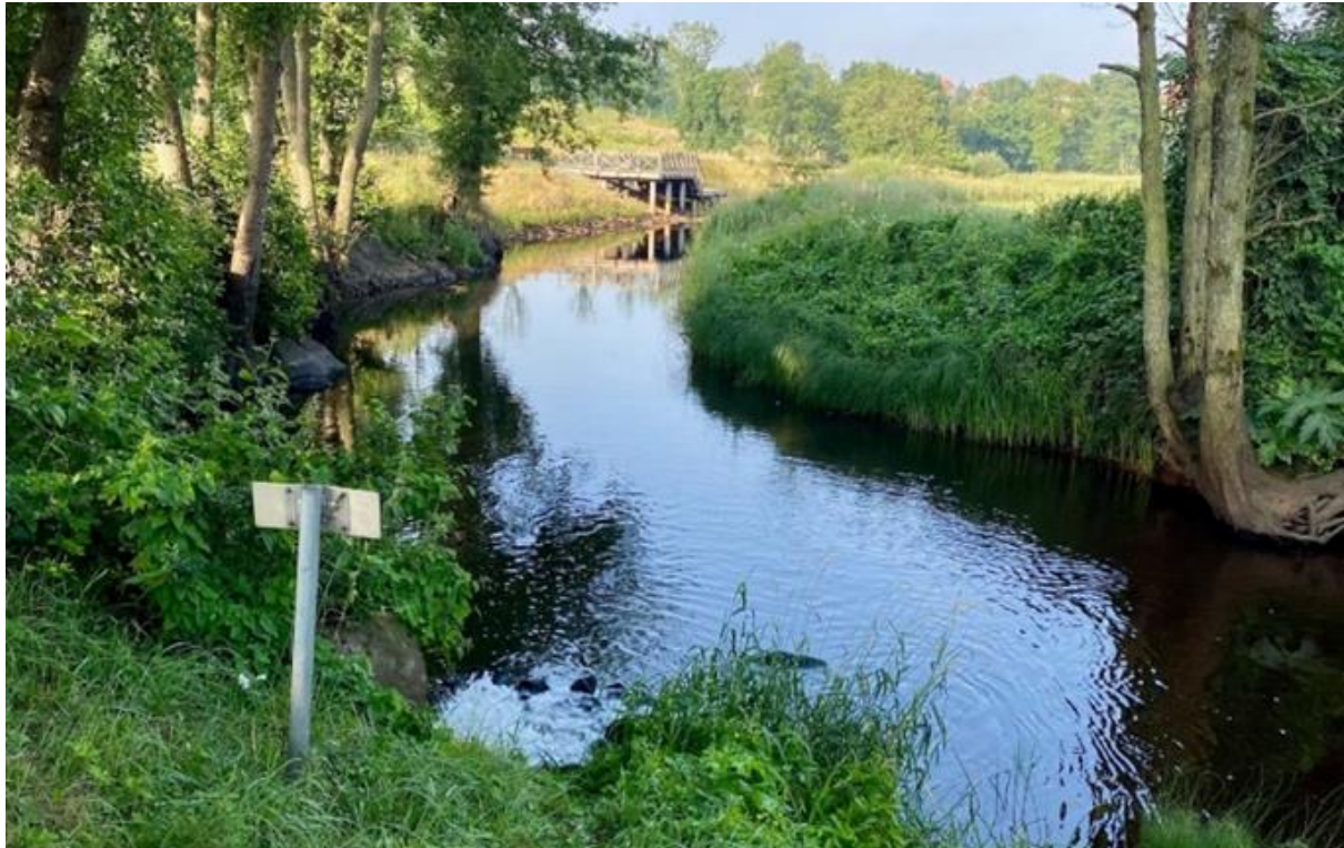
Figur 1. Utlopp till Rönne Å från Klippansavloppsreningsverk.
