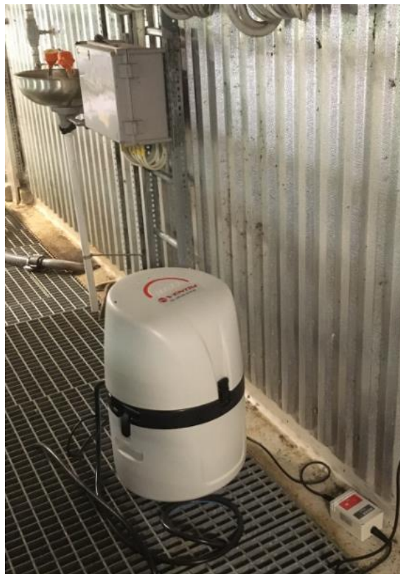
Figur 7 Portabel provtagare för provtagning av ES-vatten efter tillsatt fällningskemikalie
