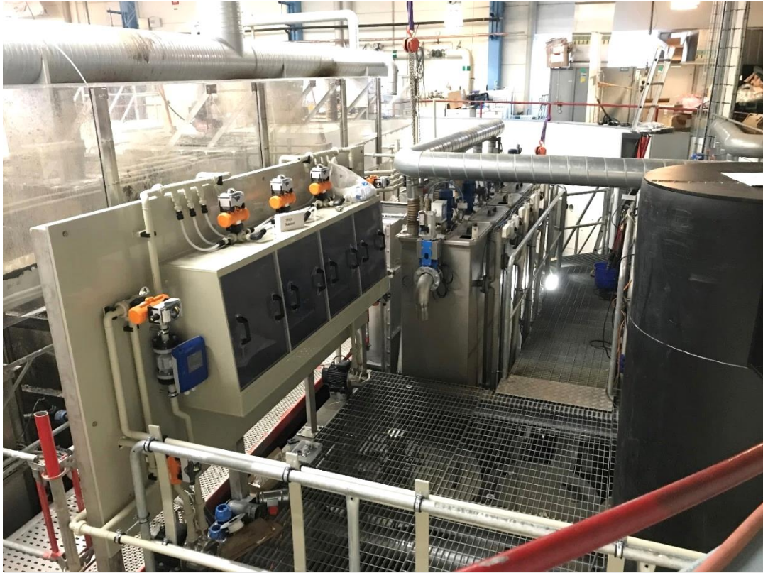
Figur 3. Vy över kemikaliestationen och de överdäckade förbehandlings och slamtankarna. I bakgrunden linje B (referenslinje) och permeattank i förgrunden.
