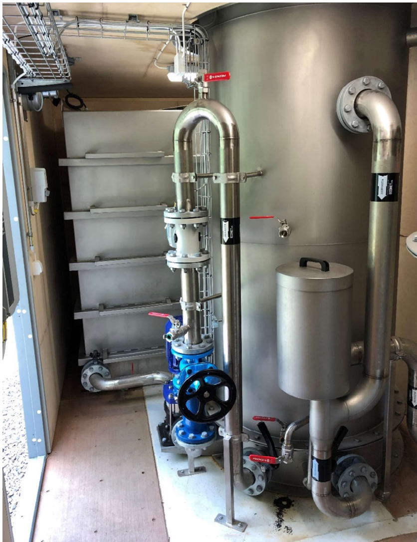
Figur 3. Sista steget efter ozonbehandlingen med kolfilter.
