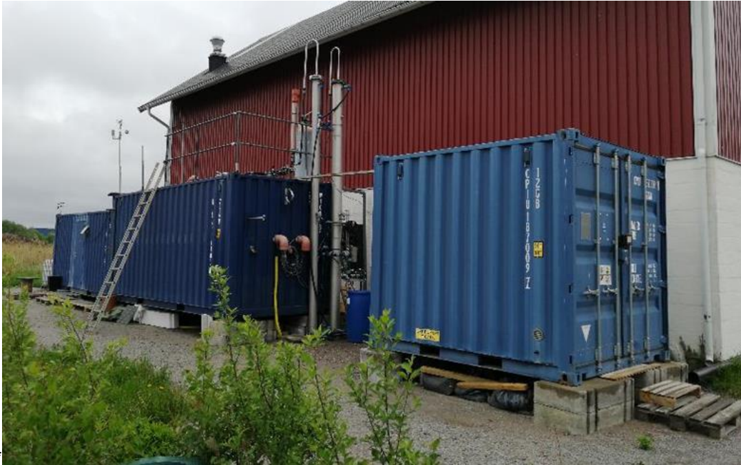
Figur 1. Pilotanläggningen med 5 m höga ozonkontaktkolonner. Akvariecontainern för fiskexponering i förgrunden och byggnaden med dynasandfilter i bakgrunden.
