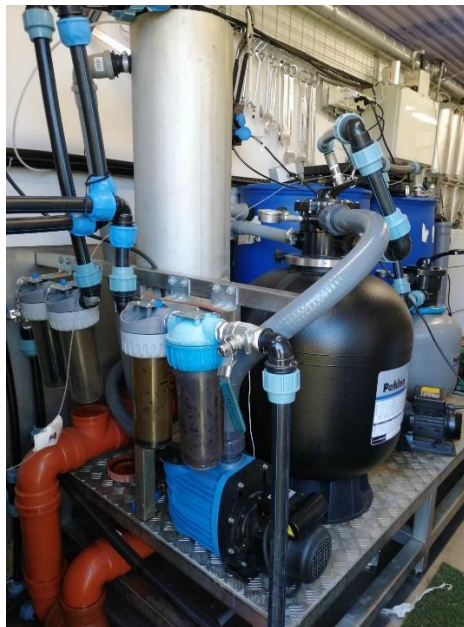
Figur 4. Förbehandling med grovfilter, förfilter och filtrattankar
