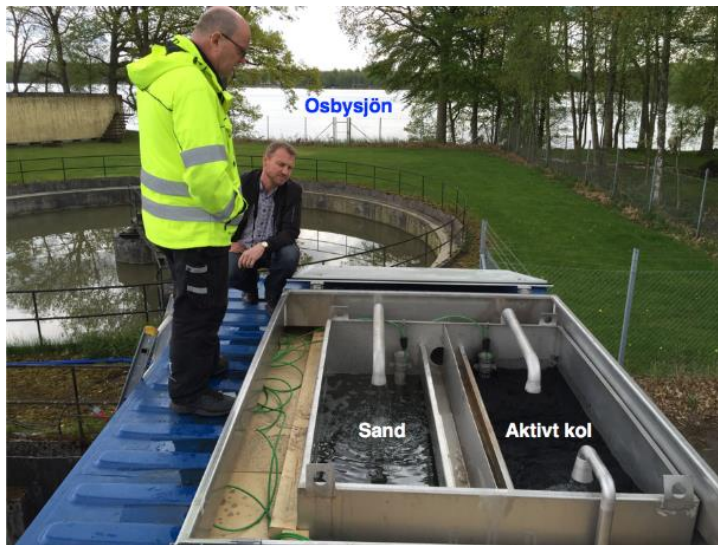
Figur 10. Bild över anläggningen med filtrering av utgående renat avloppsvatten på Osby reningsverk (Skåne), först genom sand och därefter granulerat aktivt kol (GAK). Till vänster konstruktör Måns Hansson, dåvarande chefsingenjör på Malmberg Water AB i Yngsjö, till höger Ola Svahn, forskare på Högskolan Kristianstad. Foto: Erland Björklund.
