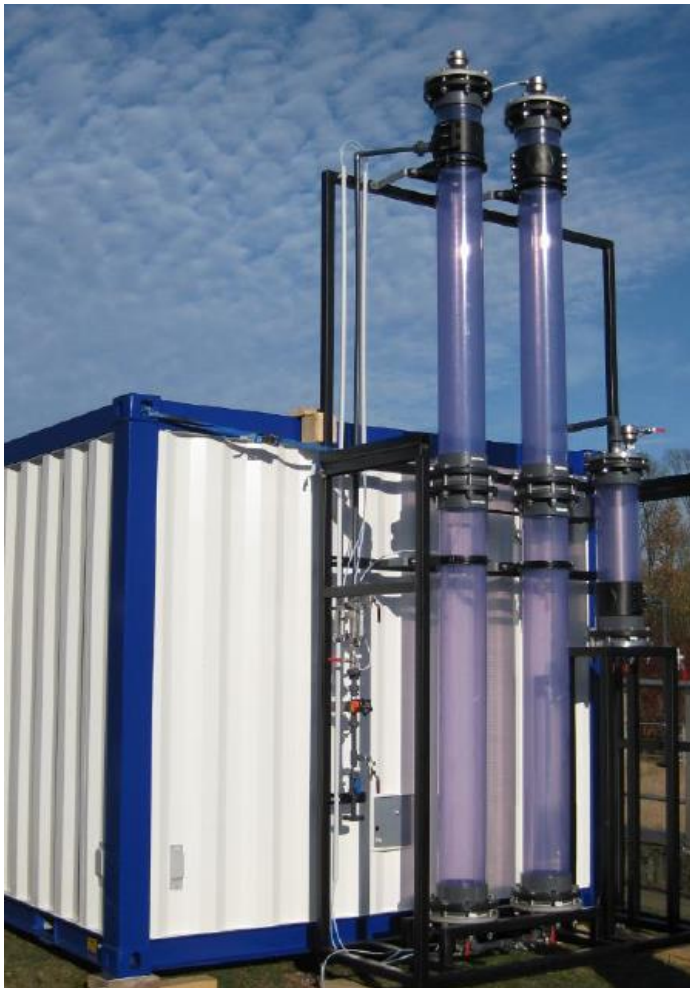
Figur 6. Pilotanläggning för ozonerings vid Nykvarnsverket.
